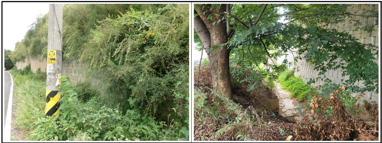
【사진 6.3.1】 지반, 기초부 전경
