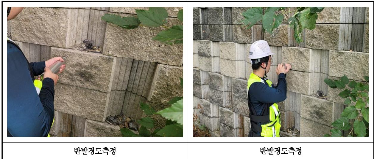
【사진 6.4.1】 재료시험 조사 전경
